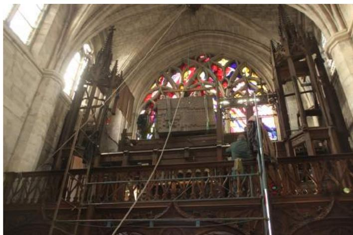
Les opérations de levage et de descente des matériels lourds ont été réalisées à l'aide d'un palan à chaîne directement accroché à la charpente de l'édifice. Ci-dessus, opérations d'extraction et de levage d'un des imposants sommiers du GO avant sa descente vers le sol.
