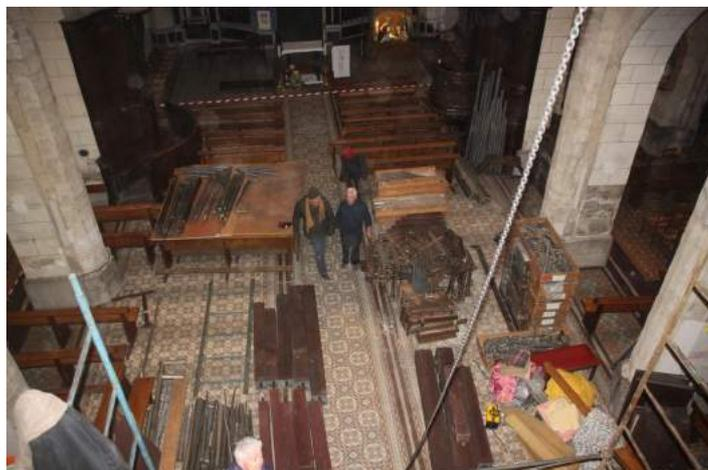
Ci-dessous, vue de la tribune à l'issue des opérations de démontage. Ne sont restés sur place que les éléments de la charpente, de l'alimentation alimentaire et du buffet. Les porte-vent ont été obstrués pour ne pas que des saletés supplémentaires n'y tombent lors des opérations de nettoyage du buffet.
